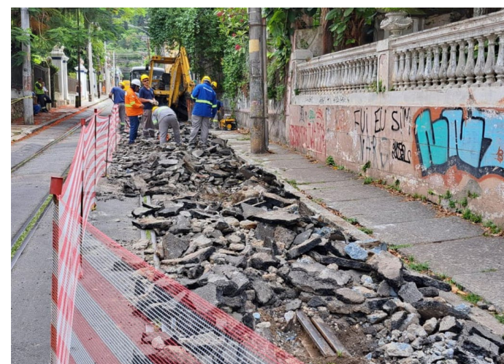
Interdições e desvios ocorrem devido a obras de reativação do bonde, no ramal Paula Mattos
