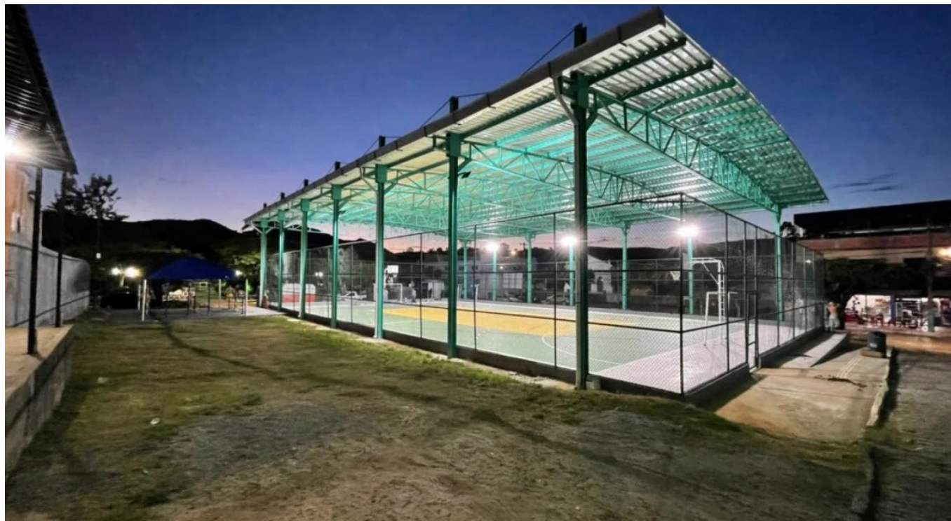
Quadra fica no distrito de Bemposta
