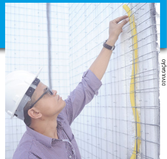
Nil Andrade, em uma casa construída com isopor. Nesta imagem, Nil demonstra como o processo de construção é simplificado ao passar o condutor elétrico pelas paredes
