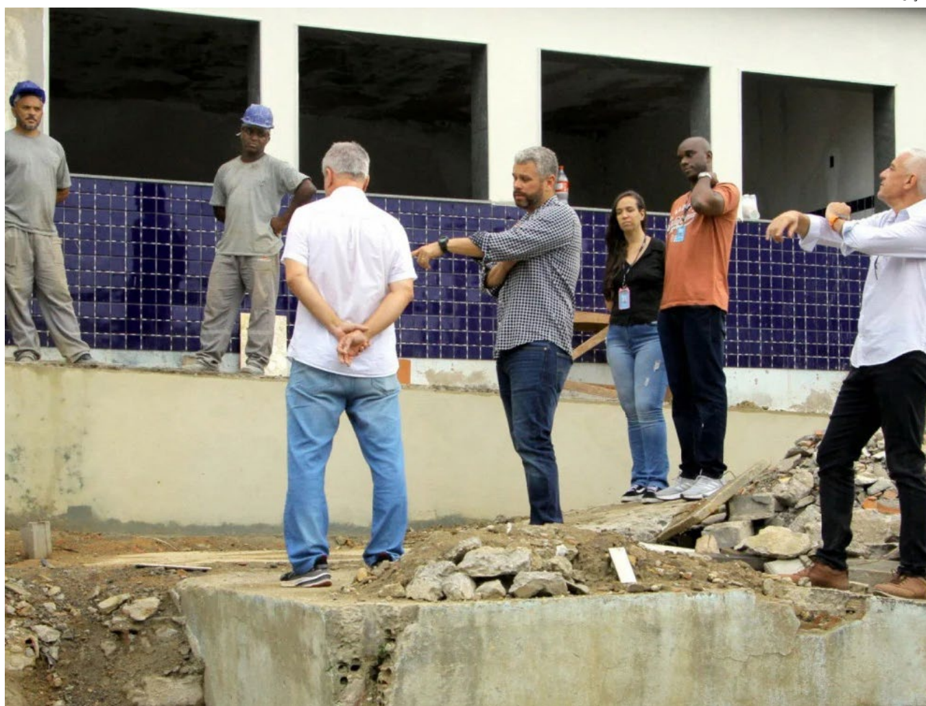
Rodrigo Drable acompanhou trabalhos em escola municipal, nas futuras instalações da creche e campo de grama sintética do bairro Boa Vista I.
