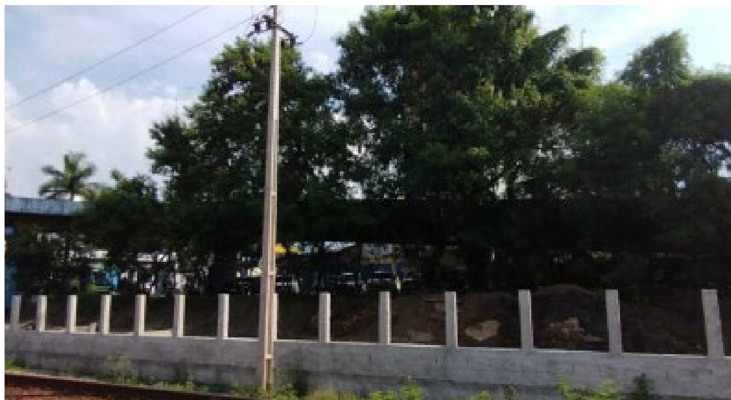
Ação se faz necessária por conta dos trabalhos de readequação ferroviária na região central do município
