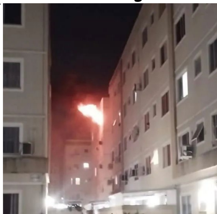
Possível curto circuito em uma tomada do quarto do casal, deu início às chamas
