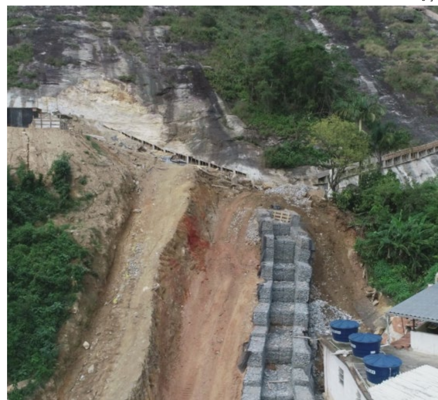
Na área 1 (entre o Hipershopping e a Rua Hercília Moret), as obras já passaram dos 50% de execução
