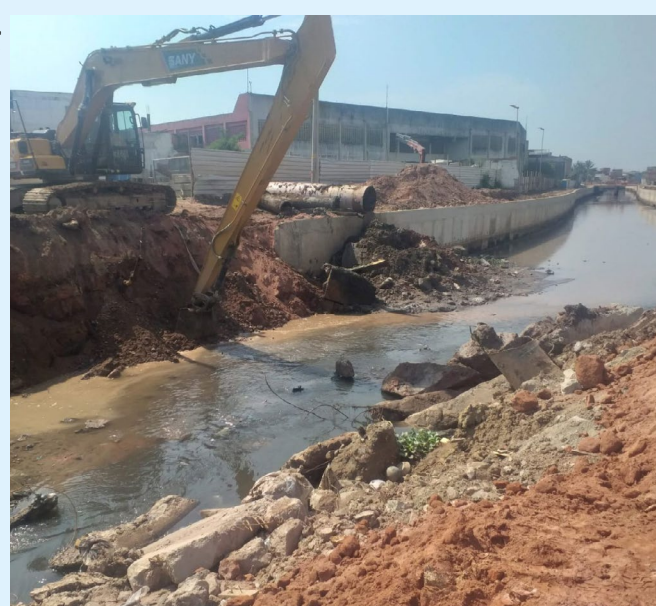
Intervenção vai beneficiar cerca de quatro mil moradores
