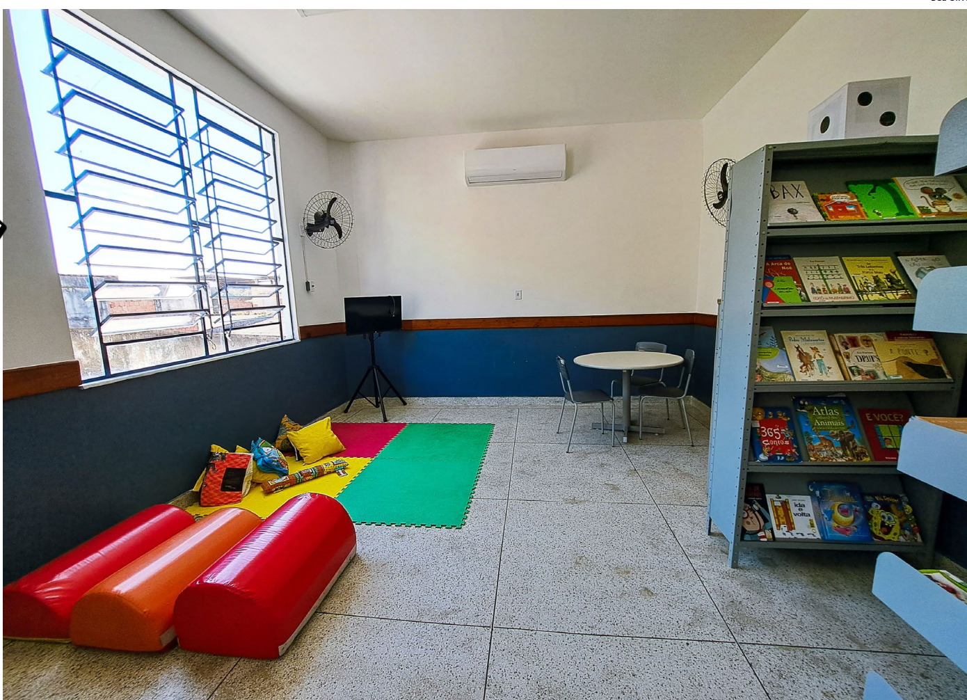
Com a reforma e ampliação, unidade ganhou novas salas e, assim, a capacidade de atendimento de alunos foi estendida de 95 para cerca de 440 vagas
