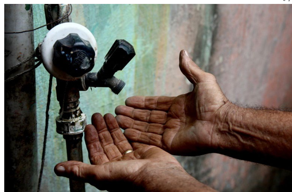
Abastecimento foi temporariamente interrompido por conta de reparo emergencial
