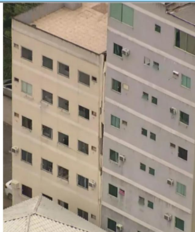
Há uma rachadura entre os edifícios e um deles está inclinado
