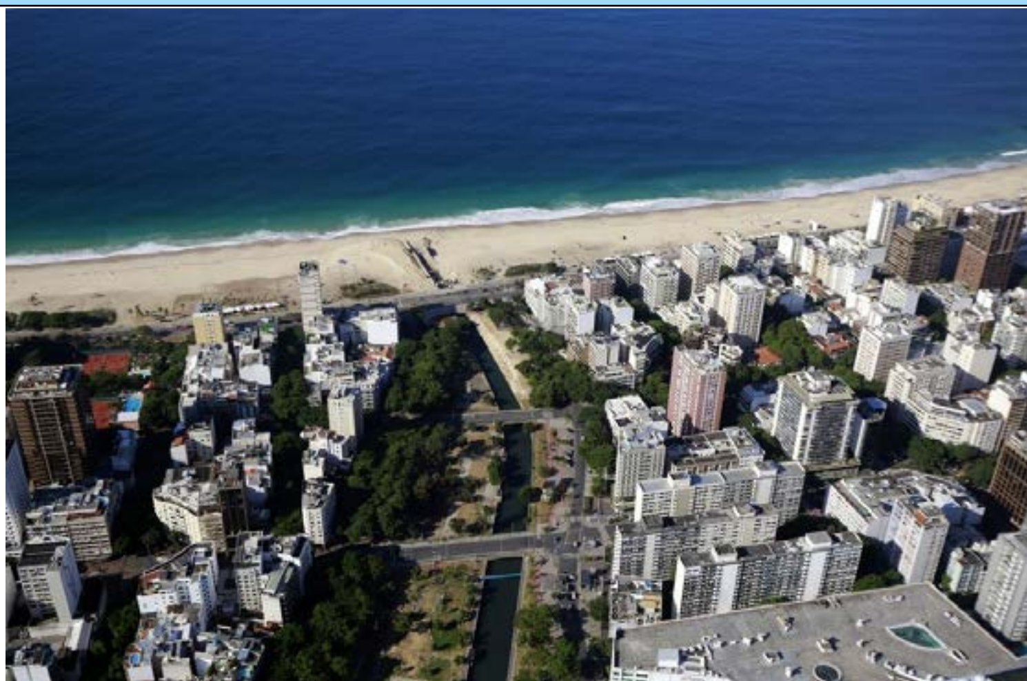
Vencedor da licitação, no entanto, ainda depende do recurso do segundo colocado. Projeto inclui a construção de lojas e restaurantes e é criticado por moradores
