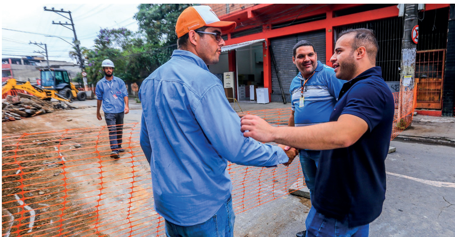
As obras do calçadão do Lote XV estão a todo vapor e haverá mudanças no trânsito
