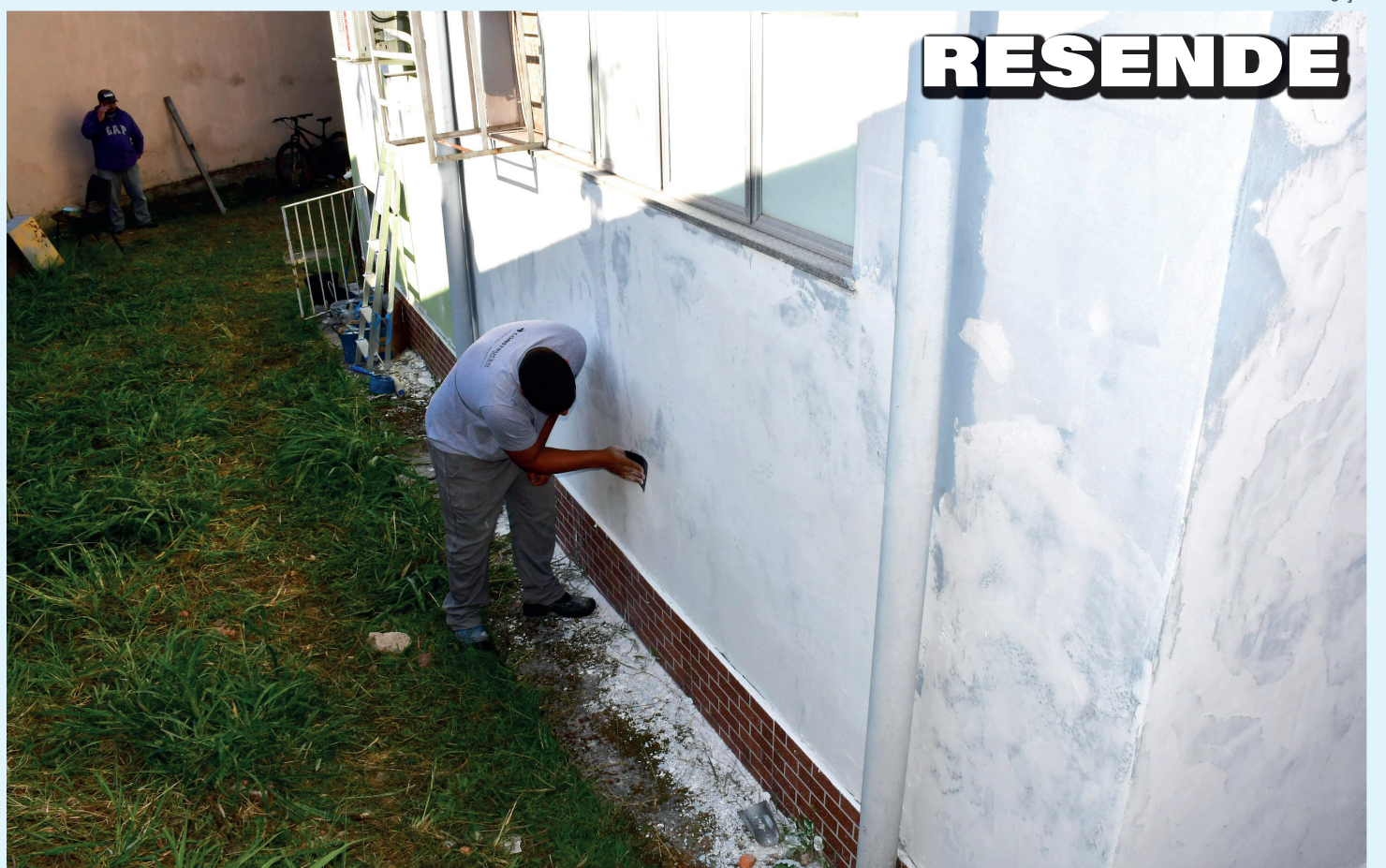
Os PSFs Liberdade e Surubi passam por intervenções de melhorias
