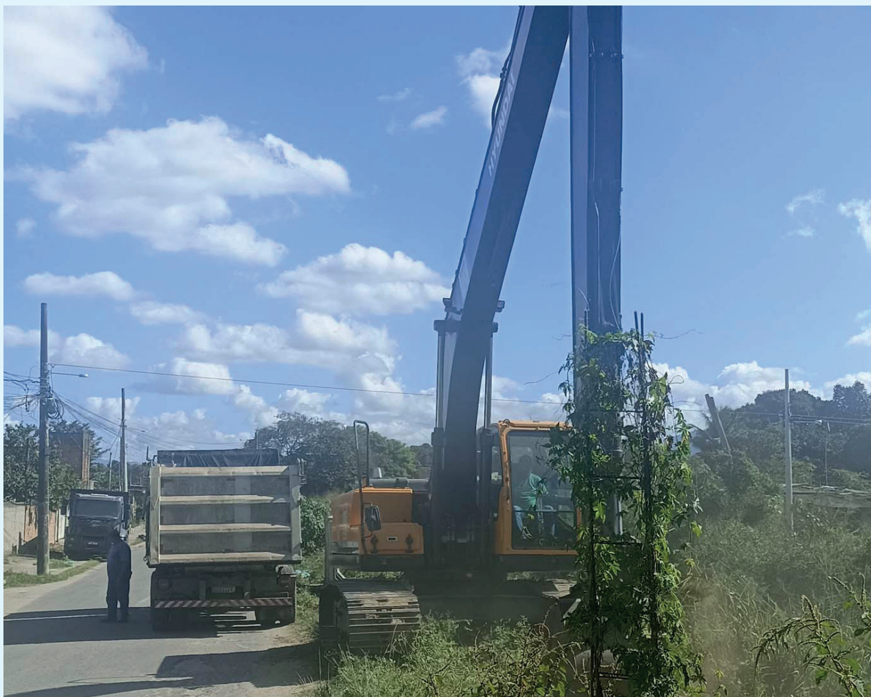
No local será feita a limpeza e o desassoreamento em um trecho de cerca de 1.770 metros de extensão
