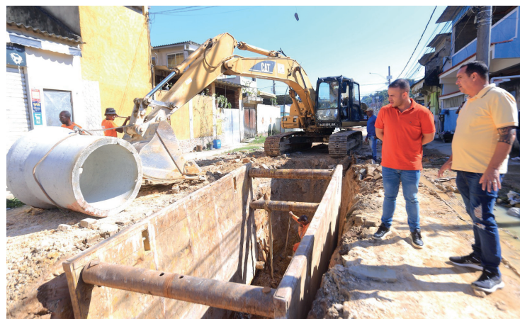
Matheus e Paulo Sérgio acompanham a colocação de manilhas em uma galeria
