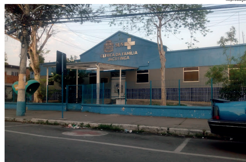
Com a reforma da unidade, atendimentos foram transferidos para um endereço provisório
