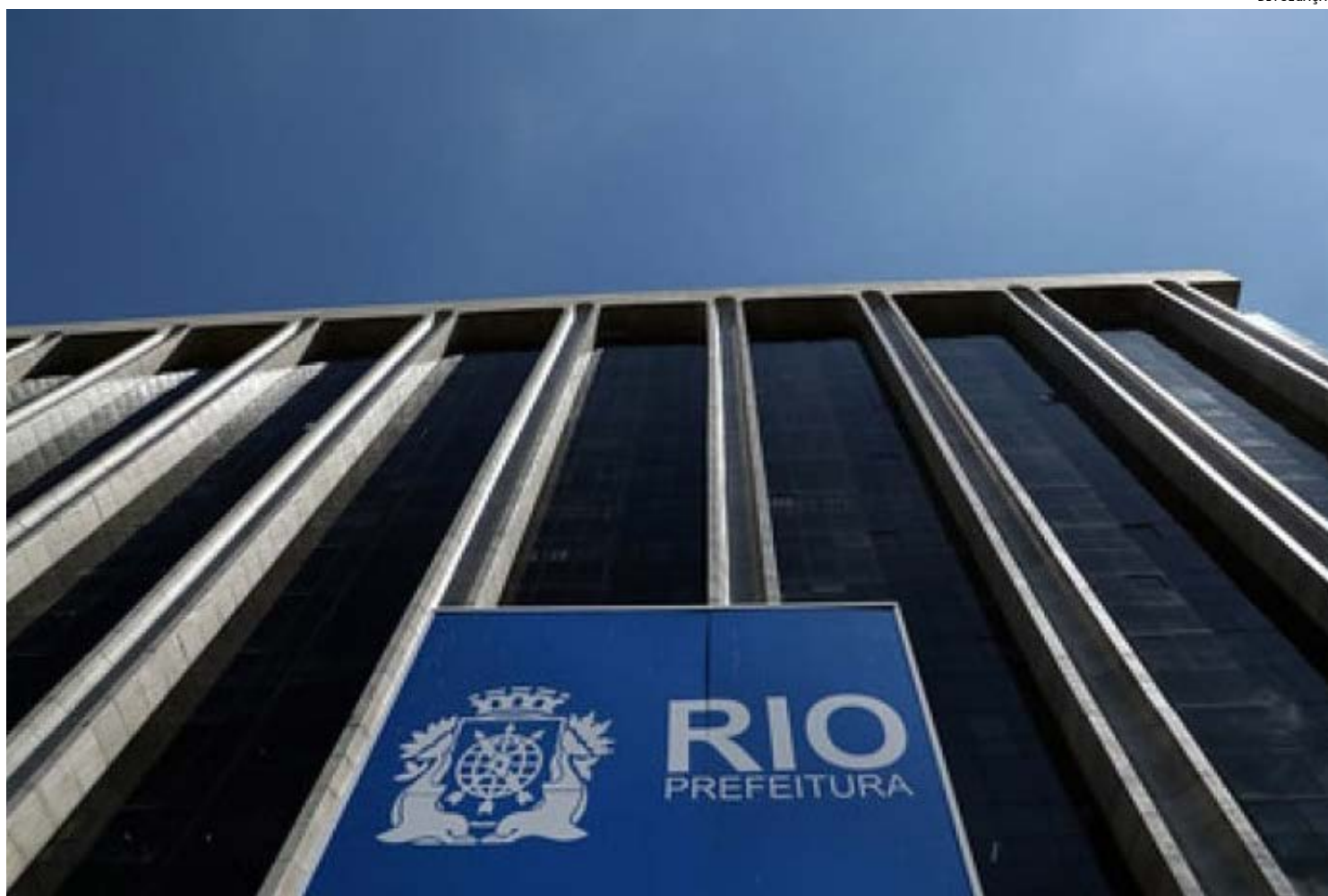
Os programas vencedores resultam na economia de mais de R$ 30 milhões nas despesas de energia na Sede Administrativa da Prefeitura, afirma o município
