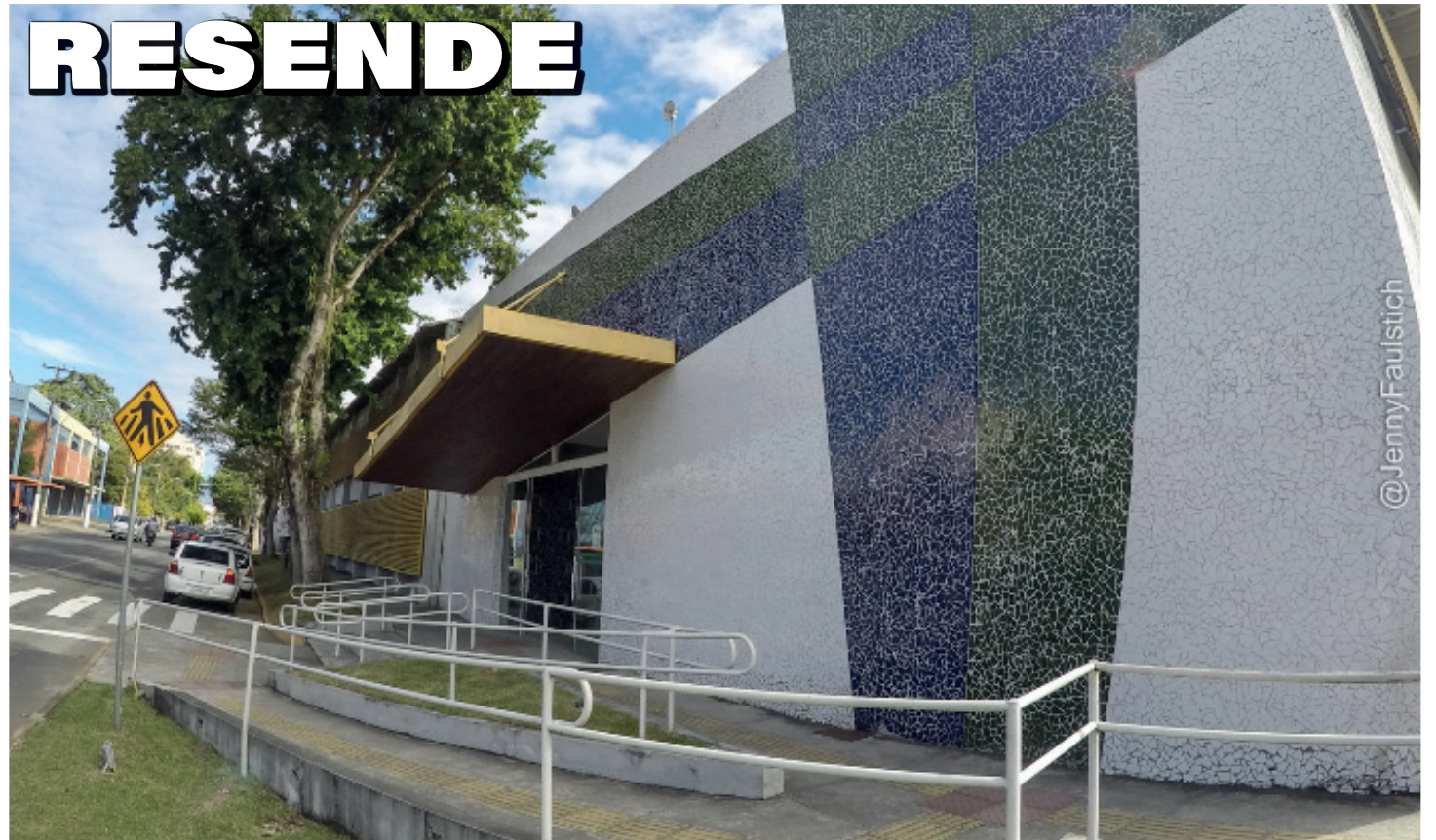
Inaugurações contemplam desde construções do zero até reformas de locais que estavam com problemas estruturais
