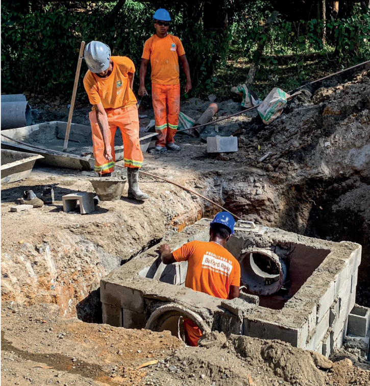
As caixas coletoras estão sendo construídas em diversas vias de Santa Tereza
