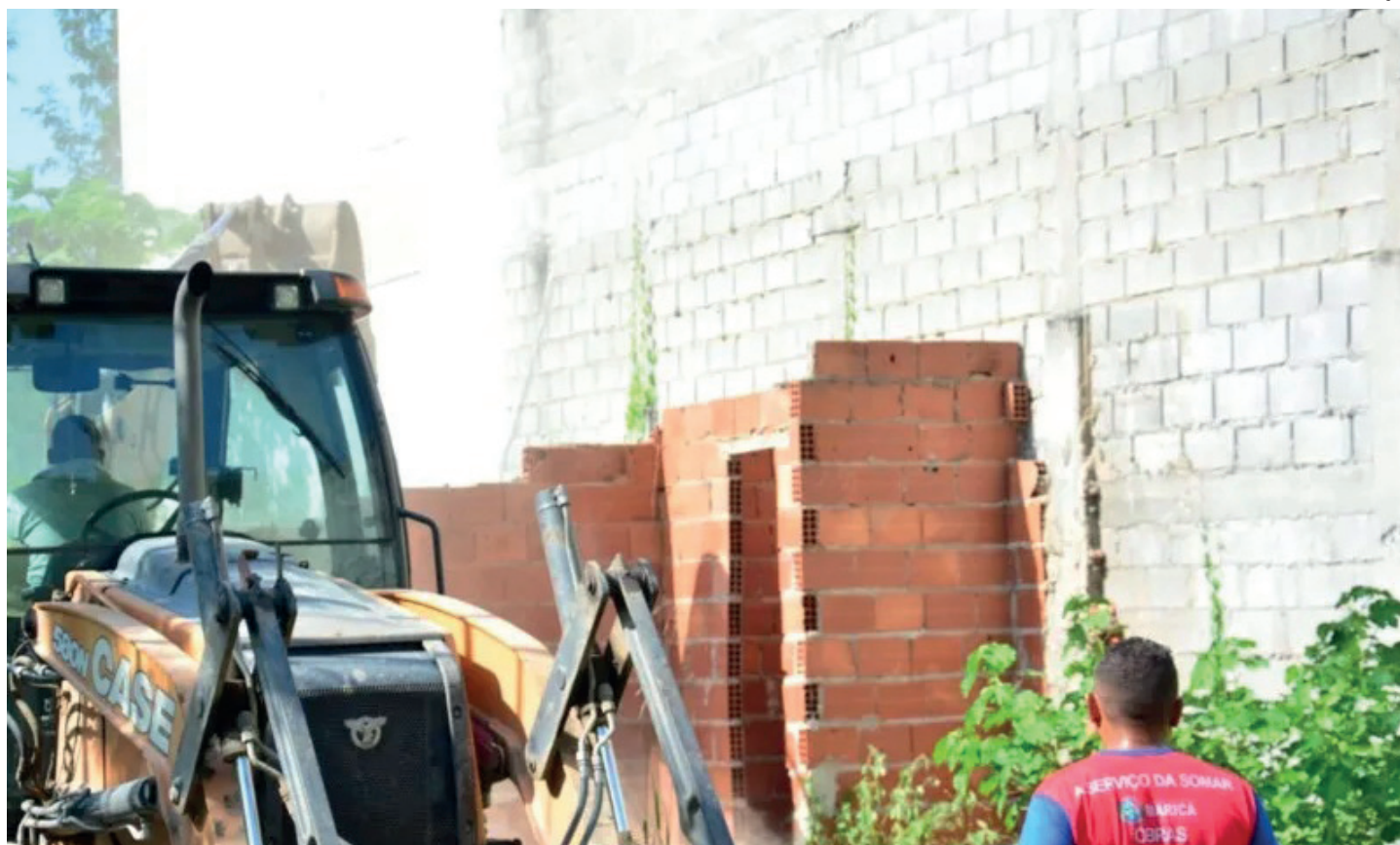
Casa, que já tinha base de concreto e paredes levantadas, foi erguida no entorno do Parque Estadual da Serra da Tiririca
