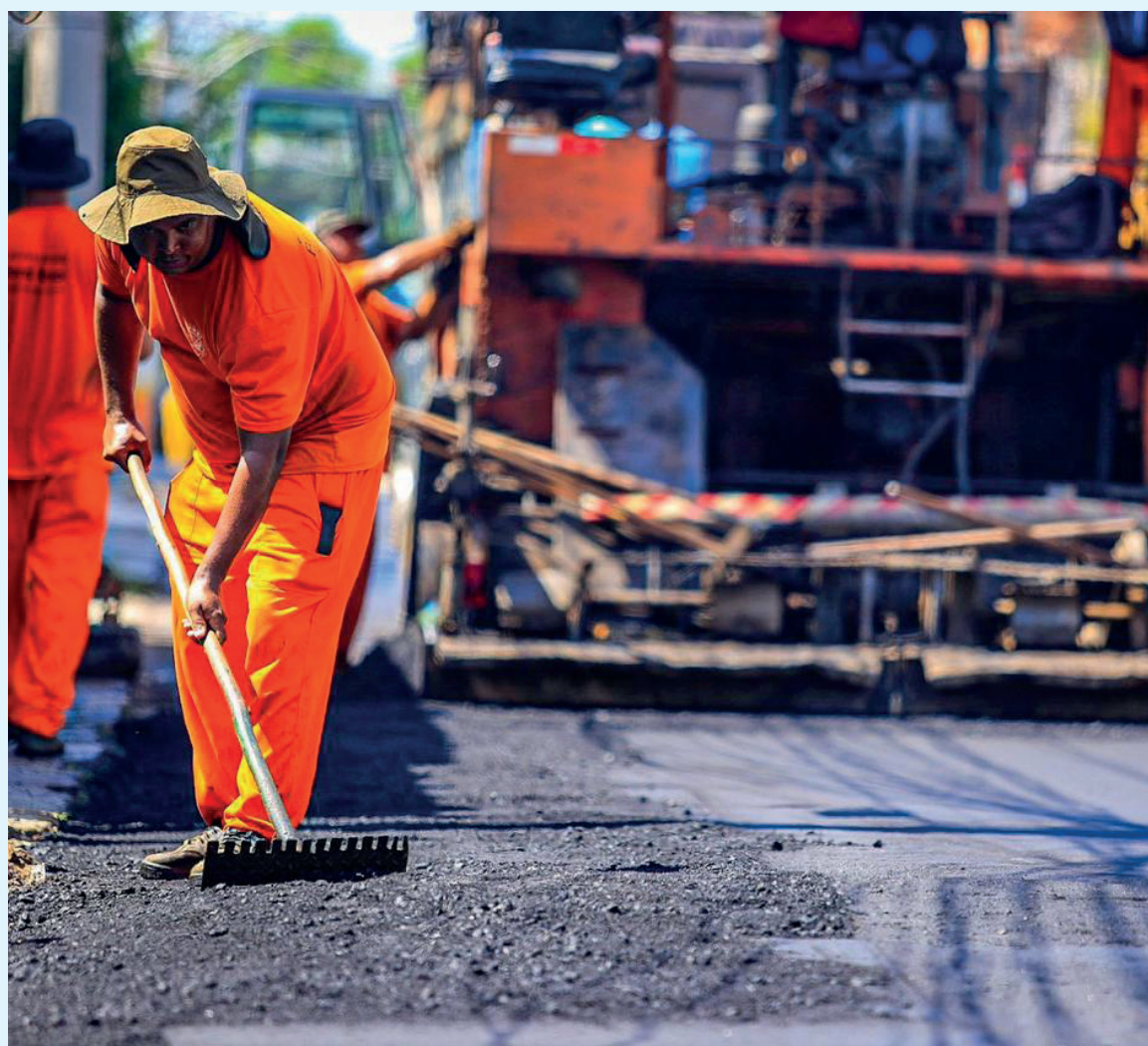
No total, a Prefeitura está utilizando mais de 1.500 toneladas de asfalto nas ruas do bairro Heliópolis
