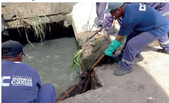
Foram retirados diversos objetos volumosos, que impedem a vazão das águas
