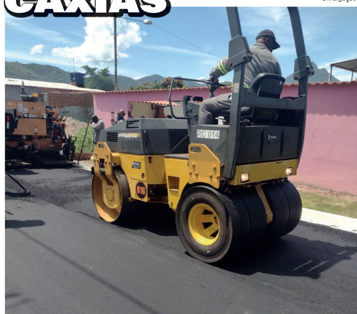
Em Imbariê, serão beneficiadas diversas ruas, com a pavimentação de 20.517 km
