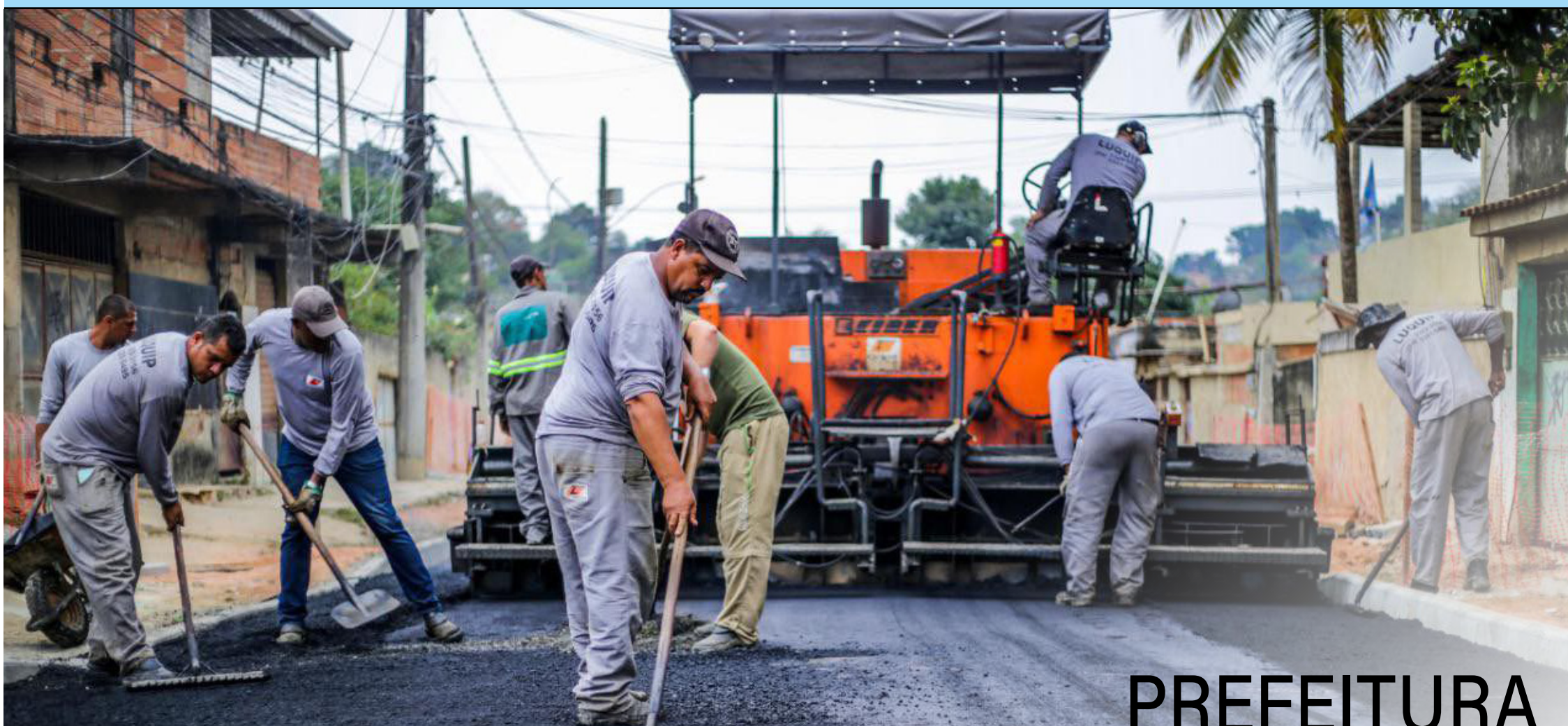
A Rua Ministro Fladelfo, no bairro Shangrilá, está sendo asfaltada
