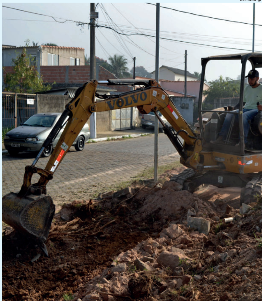
A obra total irá receber manutenção de calçadas, campo de futebol e parque infantil
