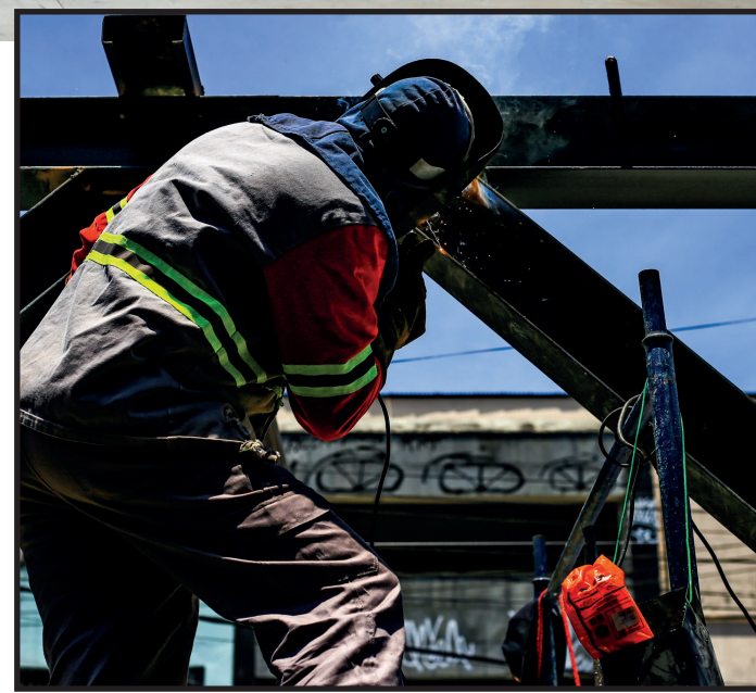
Operários estão trabalhando diariamente para concluir a obra do Mercado Popular
