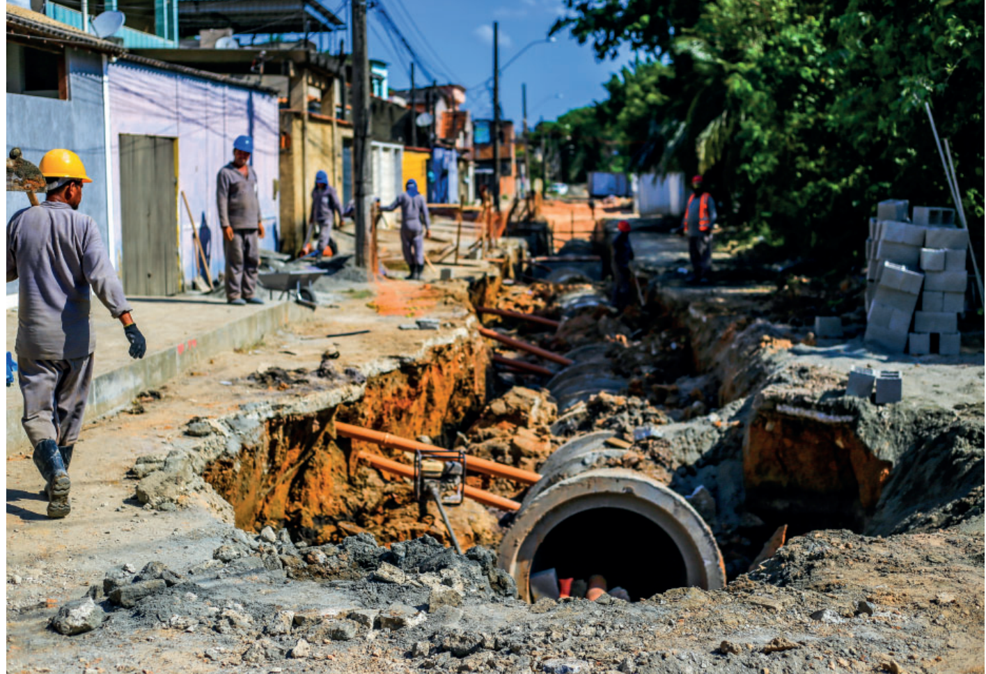
Quatorze ruas do bairro Jardim Anápolis estão recebendo obras de infraestrutura
