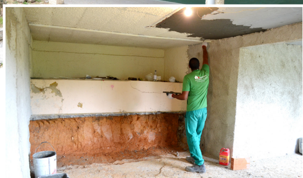
Serviços de pintura e demolição são feitos nesta primeira etapa
