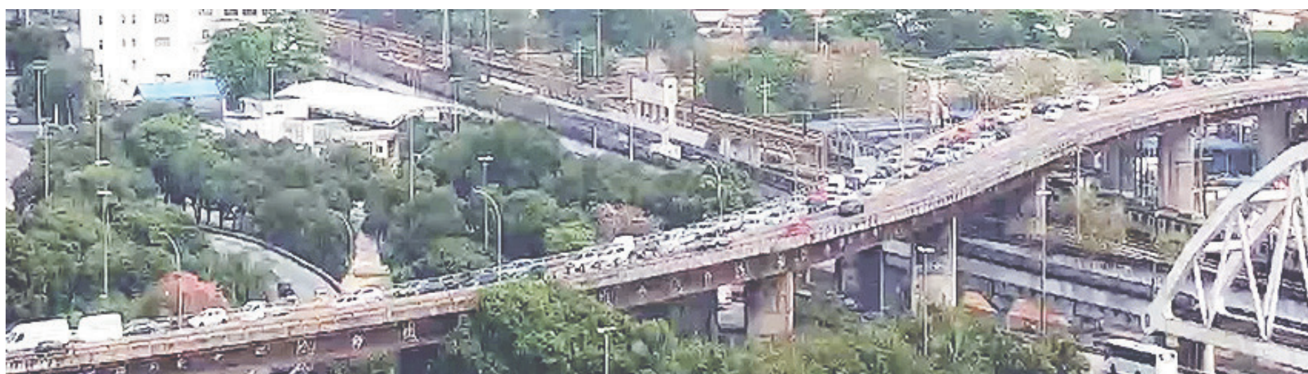
Por causa do incêndio o trânsito foi interditado nos dois sentidos do viaduto
