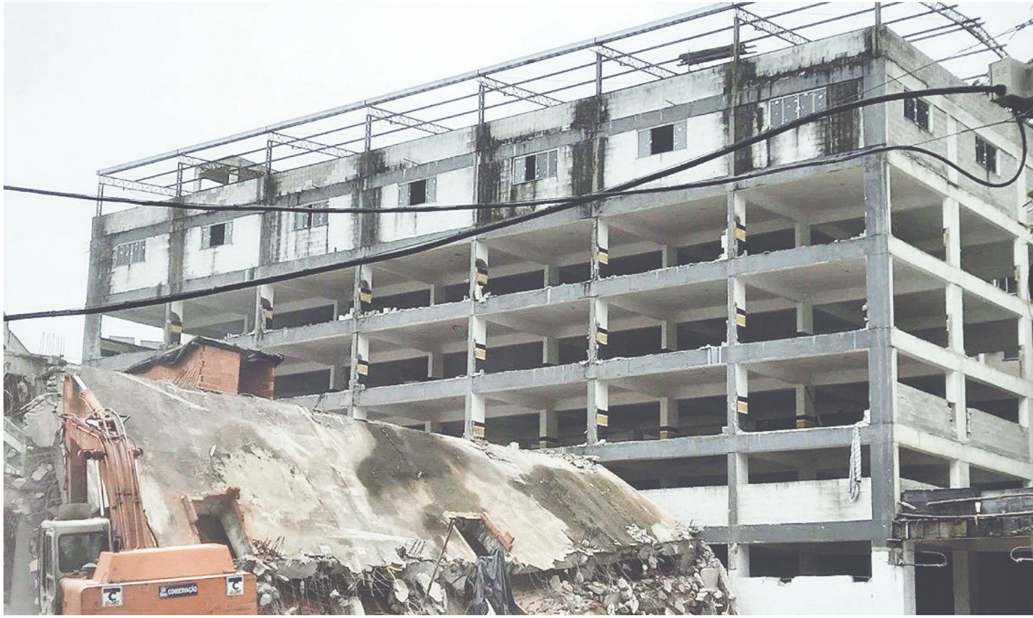
A demolição acontece a partir de uma decisão judicial
