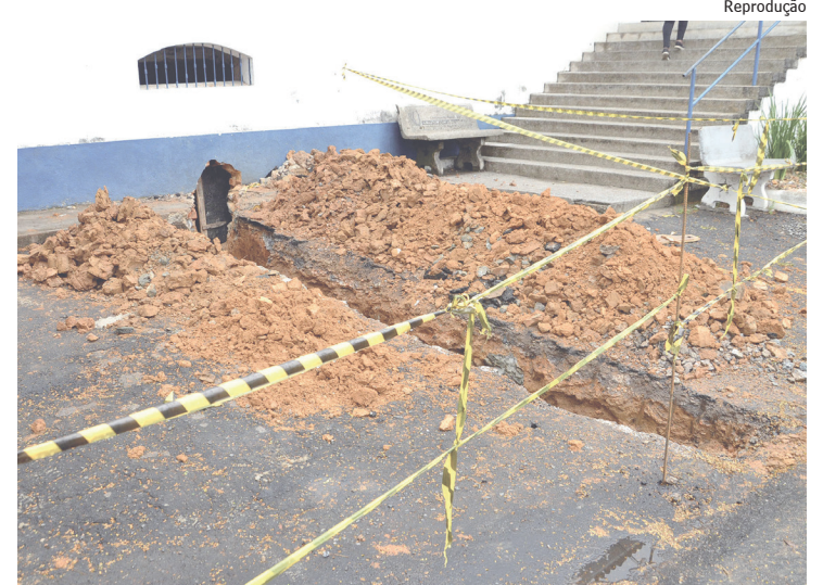
Aumento no número de atendimento trouxe a necessidade de ampliar a infraestrutura de saneamento da rede de esgoto
